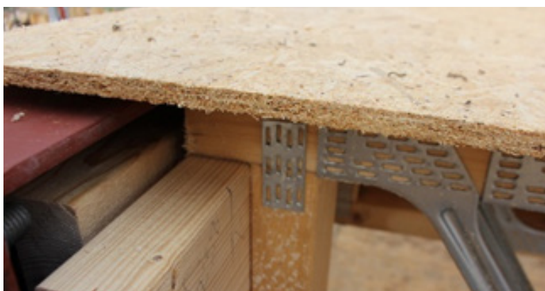
Opplegg mot stålbjelke uten bjelkesko.
