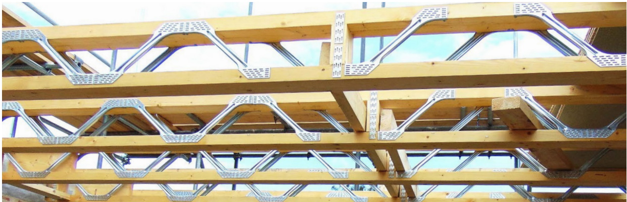
Omlegg på tverravstivninger.
