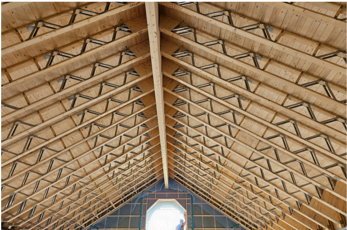
Posi-systemet som brukes i takkonstruksjon: Posi-Rafter
