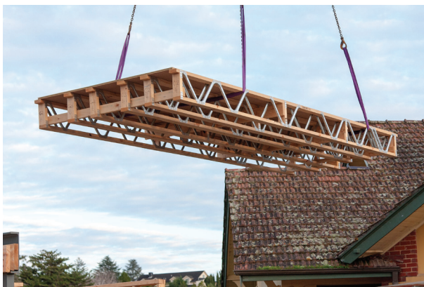
En Posi-Joist-gulvkassett løftes på plass med kran.
