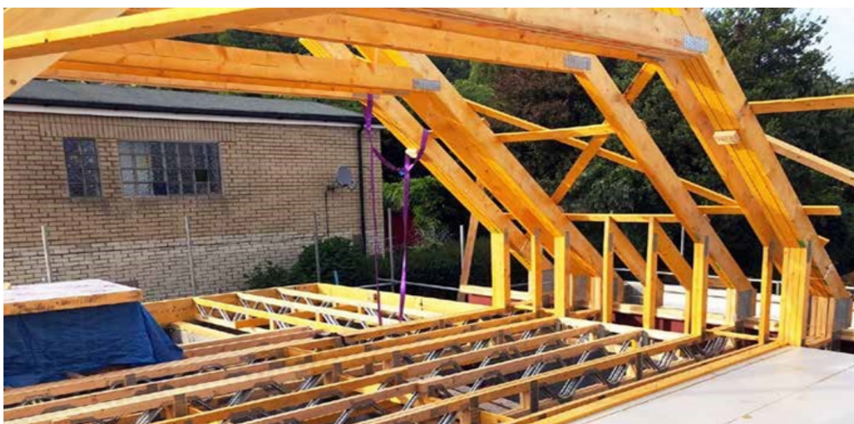
Posi-Joist-bjelkelag kombinert med et tradisjonelt loftrom.
