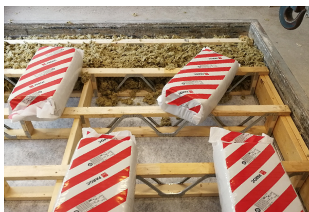
Isolering med løsuill kan gjøres allerede i fabrikk for en kassetten, eller på byggeplass.
