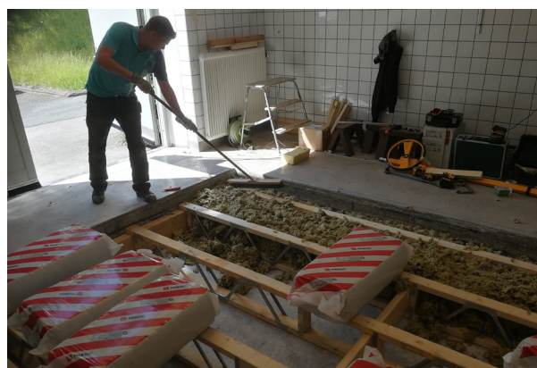
Løsuilisolering kan enkelt dekke alle tomrom i Posi-Joist-bjelkelaget.
