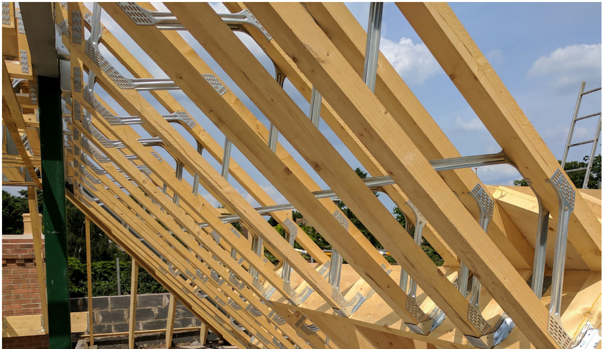
Posi-Joist for hvelvet tak med opplegg på takbjelke av stål.
