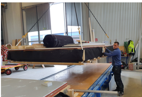
Løfting og flytting av Posi-Joist-kassett i fabrikk.
