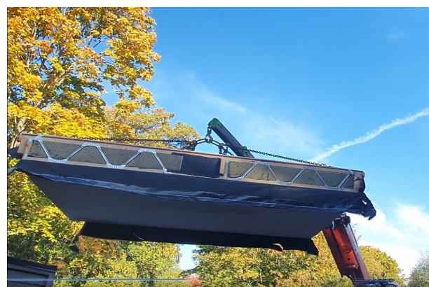
Løfting og flytting av Posi-Joist-kassett med kran.
