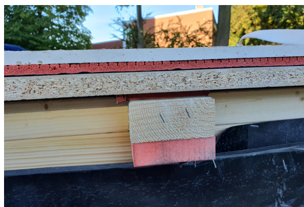
Vi ser en vibrasjonsdempere fastlimt på Posi-Joistens overgurt.
