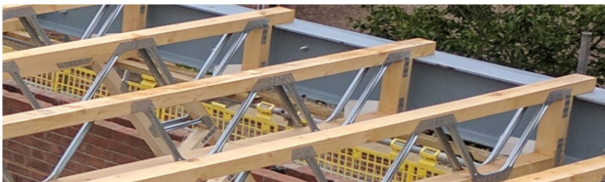
Posi-Joist med overgurt hvilende på stålbjelkens topp.
