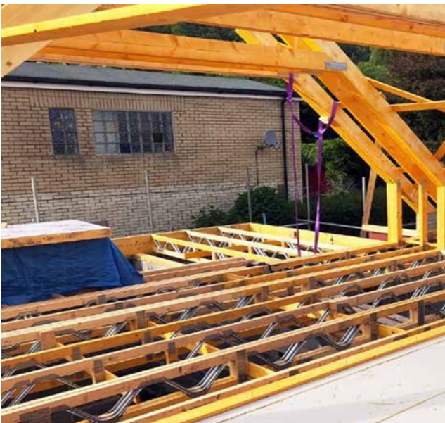
Posi-loftrom på byggeplass.
