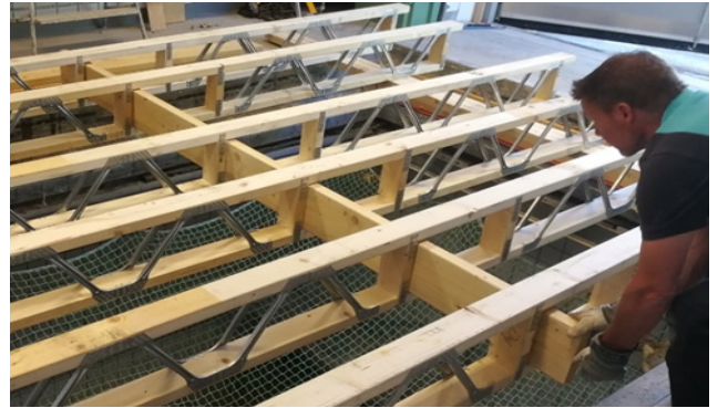
Tverravstiver monteres for spennvidder lengre enn fire meter.
