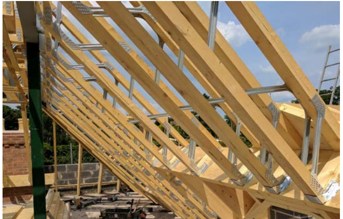
Posi-Joist-åser med opplegg på stålbjelke i mønet.
