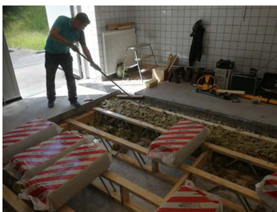
Løsullisolering kan enkelt dekke alle tomrom i Posi-Joist-bjelkelaget.
