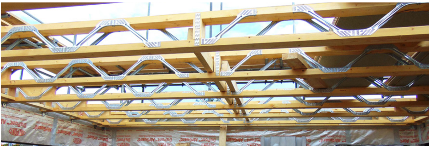
Omlegg på tverravstivninger.
