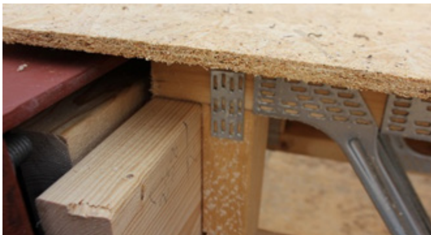
Opplegg mot stålbejelke uten bjelkesko.
