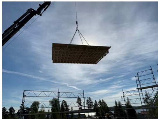
En Posi-Joist-gulvkassett løftes på plass med kran.
