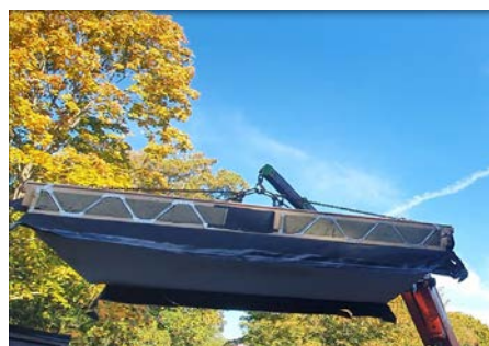
Løfting og flytting av Posi-Joist-kassett med kran.
