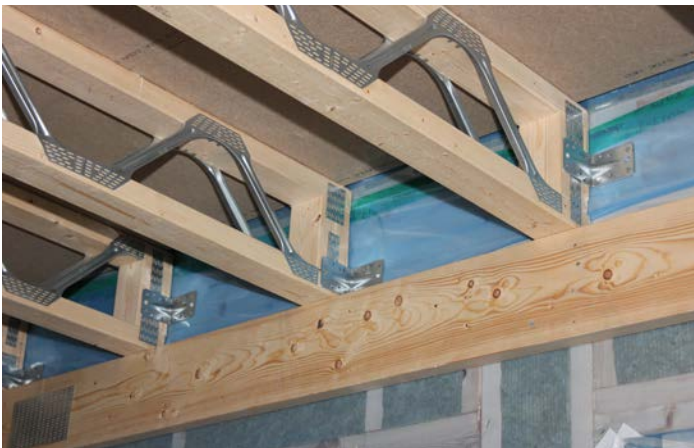
Her hviler Posi-Joists på fastsatt horisontal bjelke. For å få bedre og sikrere stabilitet under montering har man festet med vinkelbeslag (merk at eksisterende spikerplate ikke skades).
