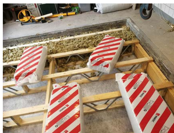
Isolering med løsull kan gjøres allerede i fabrikk for en kassetten, eller på byggeplass.
