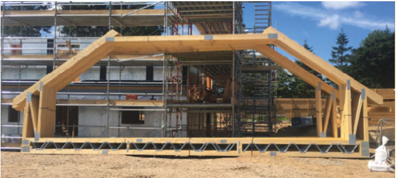
Posi-Joist-bjelkelag kombinert med et tradisjonelt loftrom.
