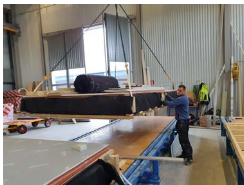
Løfting og flytting av Posi-Joist-kassett i fabrikk.
