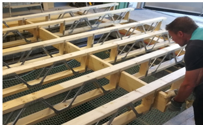
Tverravstivning monteres for spennvidder lengre enn fire meter.
