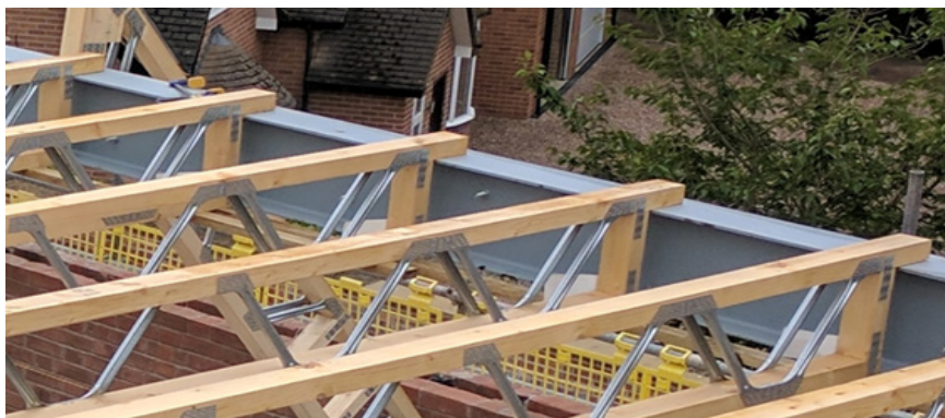
Posi-Joist med overgurt hvilende på stålbejelkens topp..
